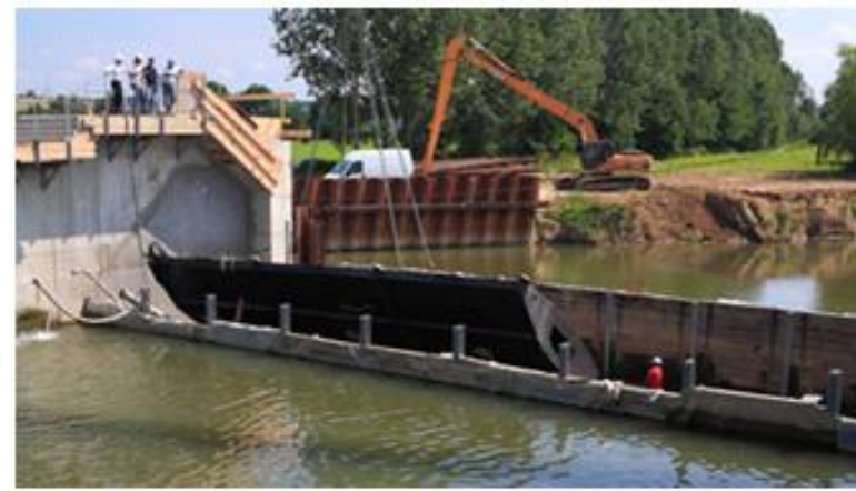
Pose du clapet
