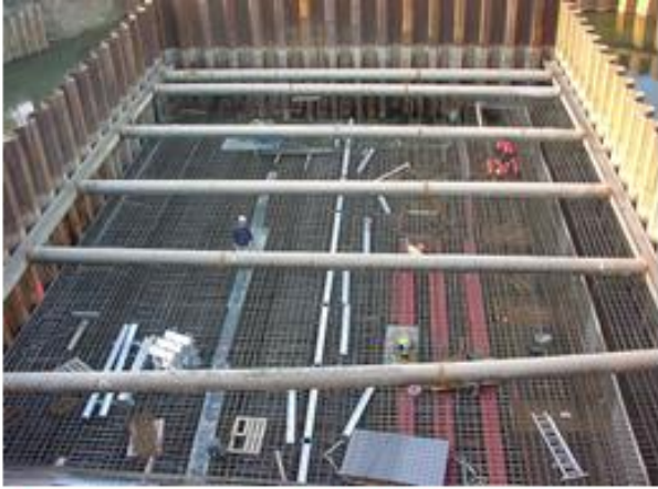
Ouvrage central : structure du béton armé
