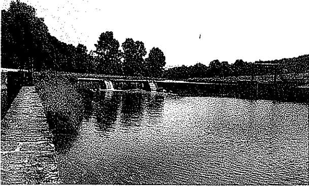
Photo 36 : Vue générale aval du seuil de Prat Pourric en période d'étéage avec l'échancrure sur le déversoir droit. Au centre du seuil, la passe à poissons. En rive droite, l'écluse et en rive gauche, le pertuis.
