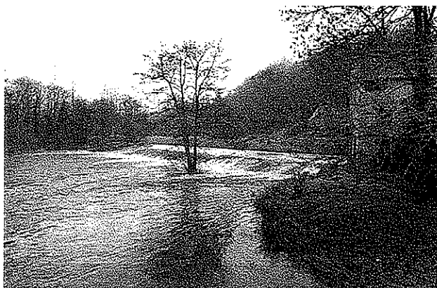
Photo 60 : Vue générale aval du seuil de Moulin Vert sur l'Aulne rivière en période de forts débits avec la passe à ralentisseurs en rive droite.
