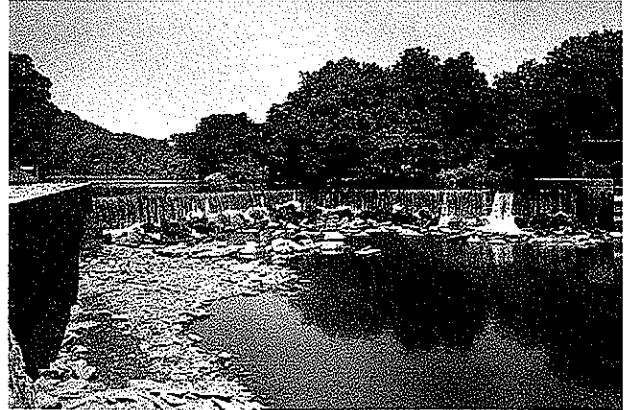
Photo 57 : Vue aval du seuil de Roz ar Gouenn et son échancrure dans le déversoir gauche en juillet 1999 avant construction de la passe à poissons. On note une présence régulière d'énrochements au pied de l'ouvrage.
