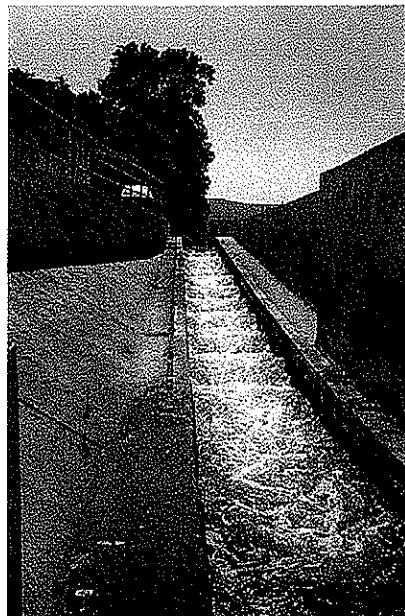
Photo 48 : Vue aval du seuil de Boudrac'h en configuration débarrée avec l'échancrure profonde au centre du déversoir.
