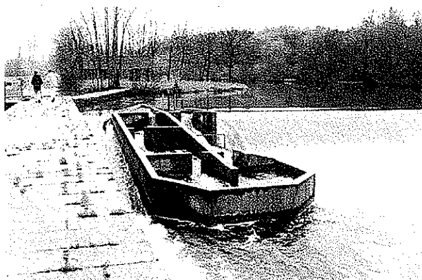
Photo 19 : Vue du seuil, de la passe à poissons et de la glissière à canoës de Penn ar Pont par débits moyens.
