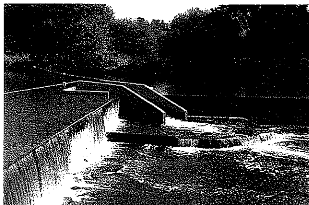
Photo 53 : Vue aval du seuil et de la passe mixte poissons-canoës à ralentisseurs de fond avec prébarrage de Goaker en période d'étiage.
