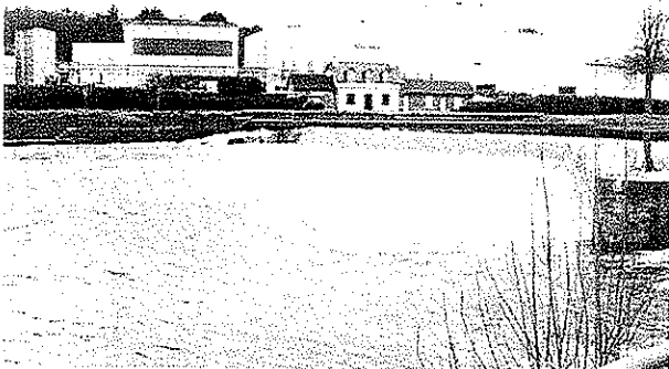
Photo 9 : Vue aval de la passe à bassins à parois déversantes de Coatigrac'h en rive droite du seuil.
