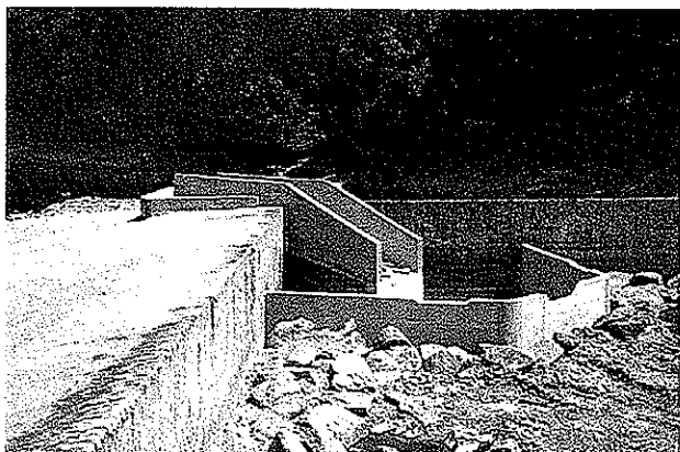
Photo 55 : Vue aval de la nouvelle passe mixte poissons-canoës à ralentisseurs de fond avec prébarrage de Rosily réalisée en juillet 1999.
