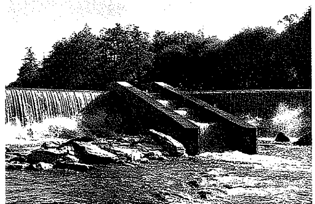
Photo 34 : Vue aval du seuil et de la passe à poissons à parois déversantes de Rosvéguen en configuration surbarrée. On note une présence régulière d'engorgements au pied de l'obstacle.
