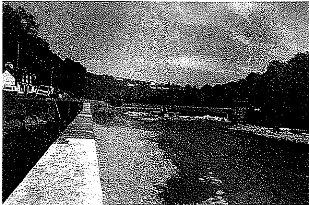
Photo 43 : Vue générale aval du seuil de Châteauneuf en configuration surbarrée (bief aval débarré). En rive droite l'écluse, au centre du seuil la passe à poissons et en rive gauche le pertuis.
