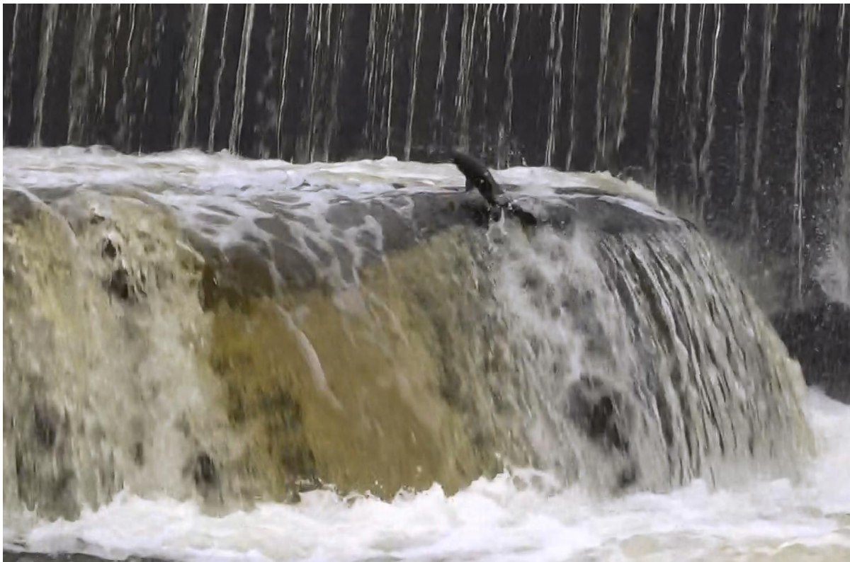
Photo 15 : passage d'un saumon dans le pré bassin de la passe à poissons en configuration surbarrée
