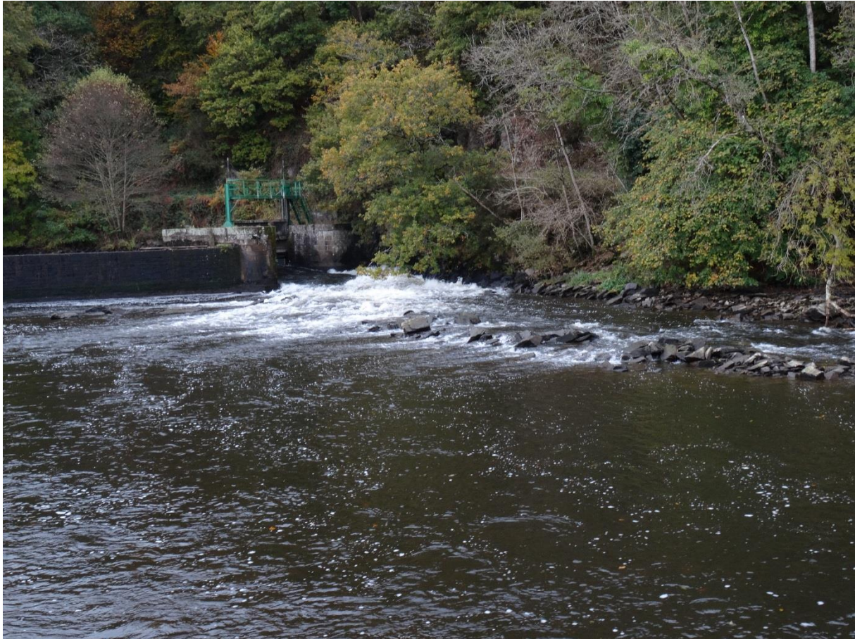
Photo 16 : aval du pertuis de Coat Pont en configuration débarrée
