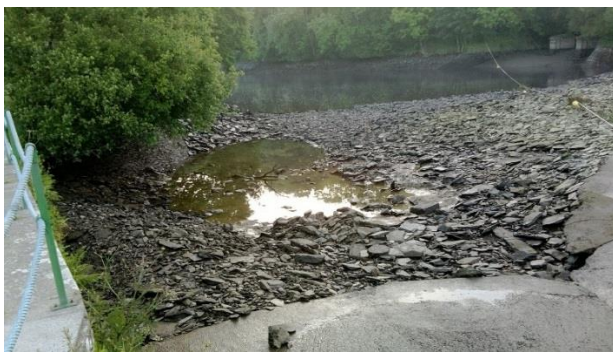
Photo 5 : Flaque à proximité du déversoir de l'Aulne
