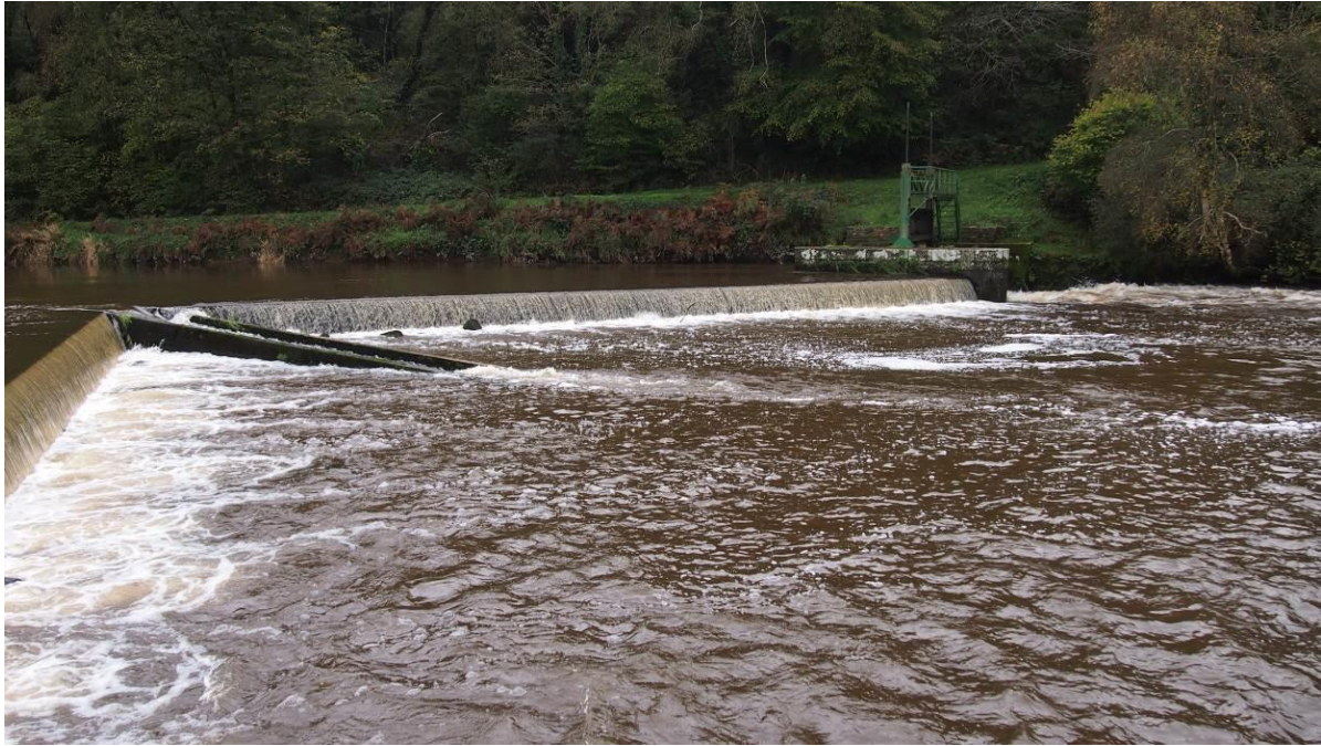
Photo 9 : Déversoir de Kersalic 8 h après l'ouverture du pertuis en novembre 2014
