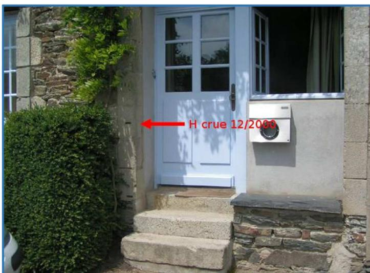
Figure 47 : Hauteur d’eau atteinte par le crue de décembre 2000 sur un enjeu déjà surélevé (terrain + marches), quai Guivarc’h (SOGREAH, 2010)
