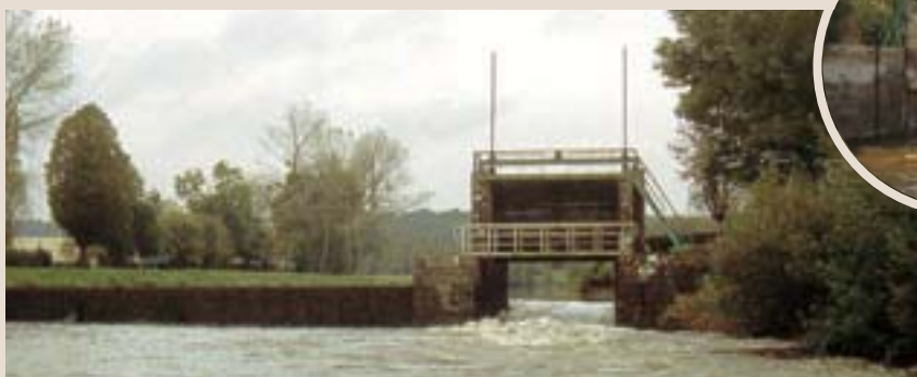
Vue d'un seuil en configuration débarrée (pertuis ouvert)
