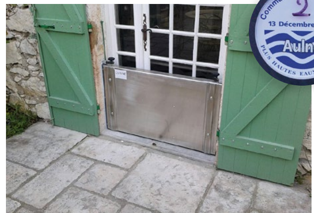
Exemple de batardeau amovible et repère de crue sur Port-Launay
