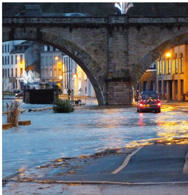
Crue de décembre 2013 à Châteaulin
